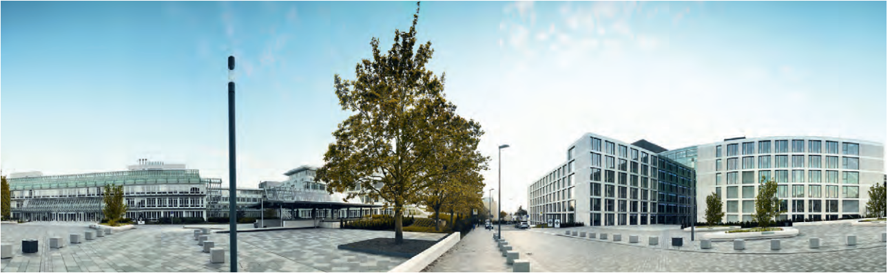
Die beiden Hauptgebäude der R+V am Wiesbadener Raiffeisenplatz in einem Bild.
