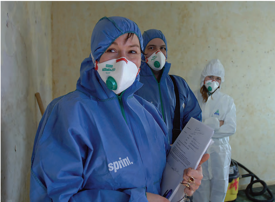
Mitarbeitende des R+V-Sanierungsspezialisten Sprint bei ihrer Arbeit in einem beschädigten Gebäude.
